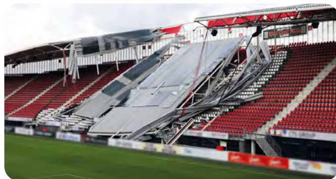
Instorting dak AZ stadion. Met keuringen zijn instortingen te voorkomen. (Bron: Onderzoeksraad voor Veiligheid)
